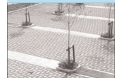
■ 그림 20. 주차장의 잔디블록 포장
